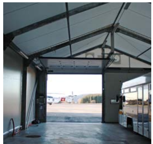
Full utnyttelse av høyden. Ingen fagverk.
